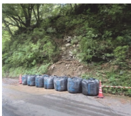
大型土のう対処事例
