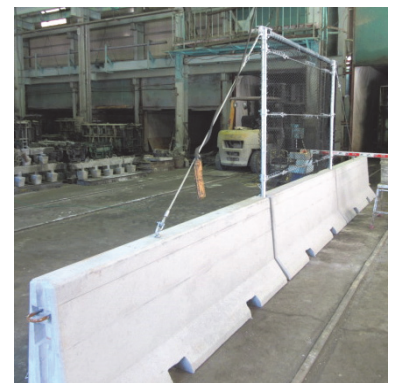
基礎擁壁に防護柵をセットした状況
