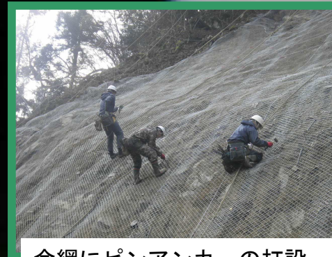
金網にピンアンカーの打設
