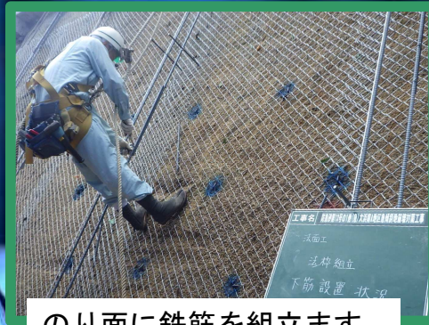
のり面に鉄筋を組立ます
