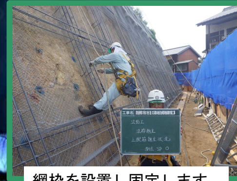
網枠を設置し固定します
